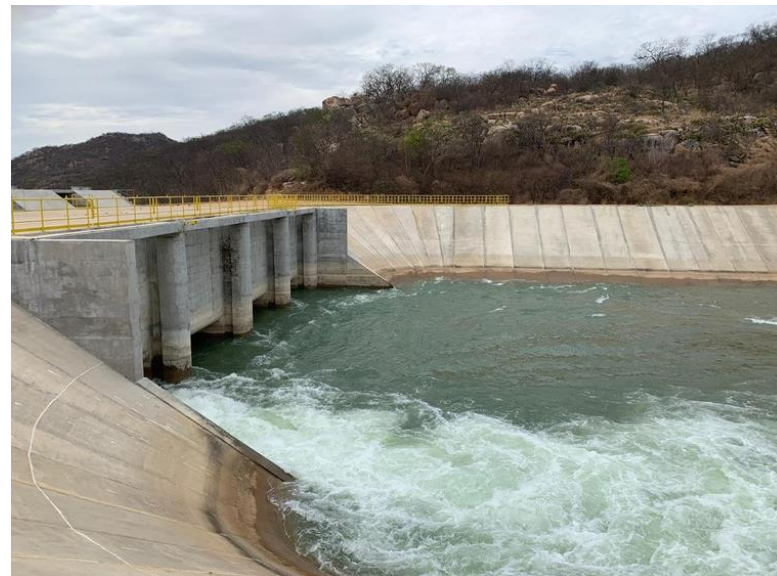
Figura 28. Estruturas do Projeto de Integração do Rio São Francisco (PISF)
