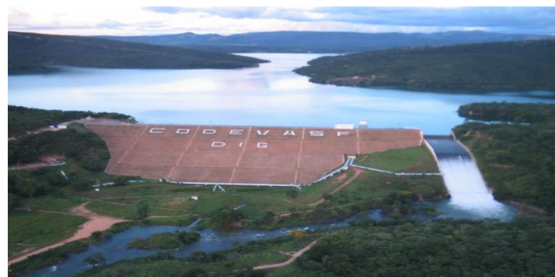
Figura 20: Barragem Bico da Pedra/MG.
