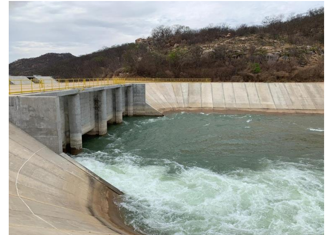
Figura 18: Estruturas do Projeto de Integração do Rio São Francisco (PISF)
