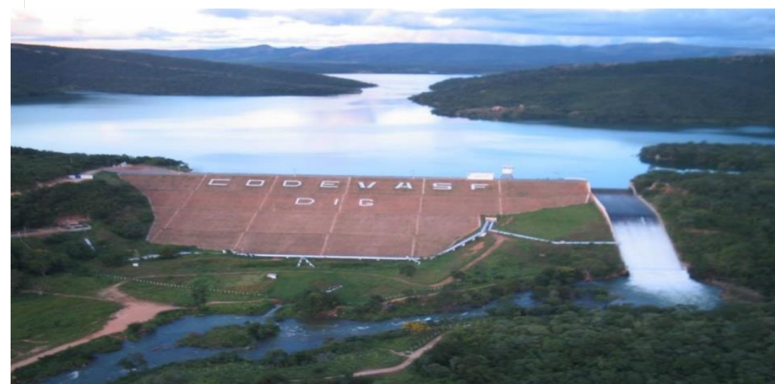
Figura 10. Barragem Bico da Pedra/MG.
