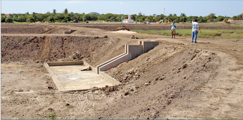
FIGURA 12 - Caixa de coleta em alvenaria
