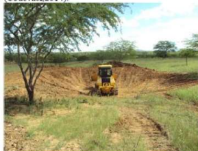
Figura 1 - Construção de Barraginha (Codevasf/2014). Figura 2 - Barraginha construída (Codevasf/2014).
