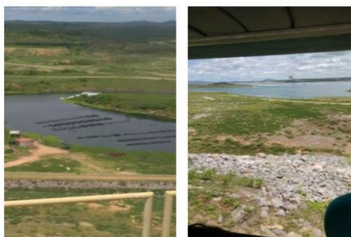
Figuras: Panorâmicas da bacia hidráulica do açude Castanhão.
