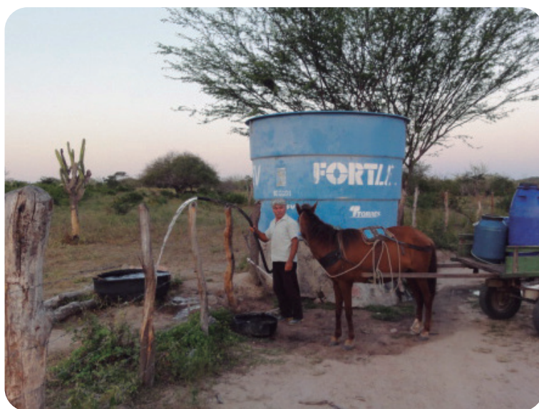
Foto 99 – Reservatório d'água do assentamento Moxotó das Areias
