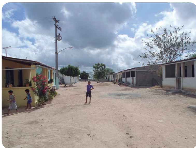
Foto 44 – Vista geral do assentamento Peba
